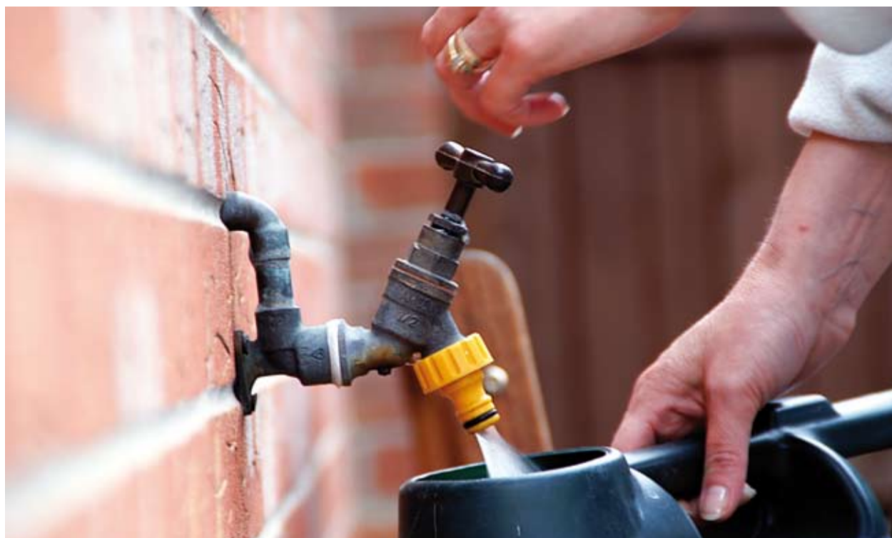
L'ensemble du réseau de la commune de Constantine est évalué à 500 km s'agissant du réseau primaire (canalisation de gros diamètre), et 700 km si l'on devait y inclure le réseau secondaire et tertiaire
